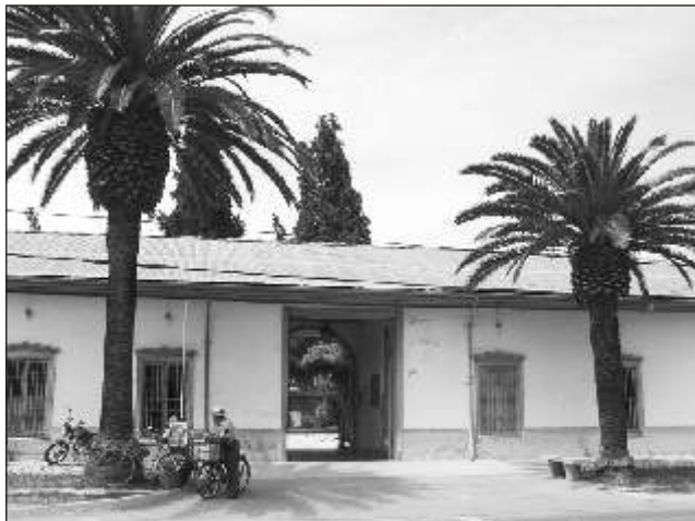
Frontis Cementerio Municipal (1858) tipo de construcción en adobe de fachada continua con amplios ventanales.
