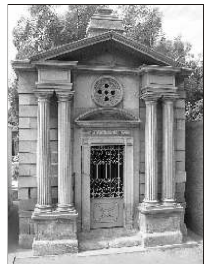
Marcial Espinola (1890) estilo clásico romano, columnas dóricas, emplazada en piedra laja color rosado.
