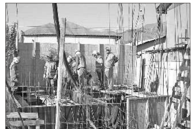
Trabajos de fundaciones para la construcción de las lozas del segundo y tercer piso se ejecutan en esta nueva obra arquitectónica.
