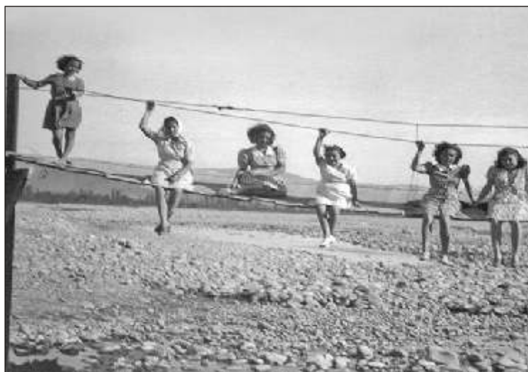
Antiguo puente colgante que une Putaendo con el sector rural de Granallas cuya construcción en base a rieles de ferrocarril y madera data de fines del siglo XIX.
